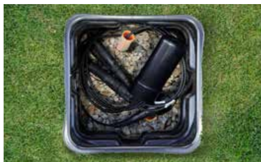
El tamaño en miniatura puede caber en orificios de registro existentes donde el espacio es limitado (Se muestra una caja de nivel de grado de 11"x11")
